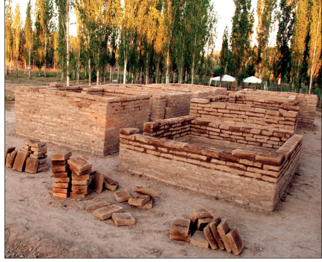
Res. 11. Kerpiç bina yapım süreci
