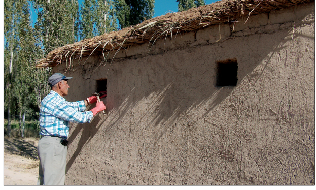
Res. 15. Model evlerde, özgün kalıntıya uygun boyutlarda yapılmış havalandırma açıklıkları
